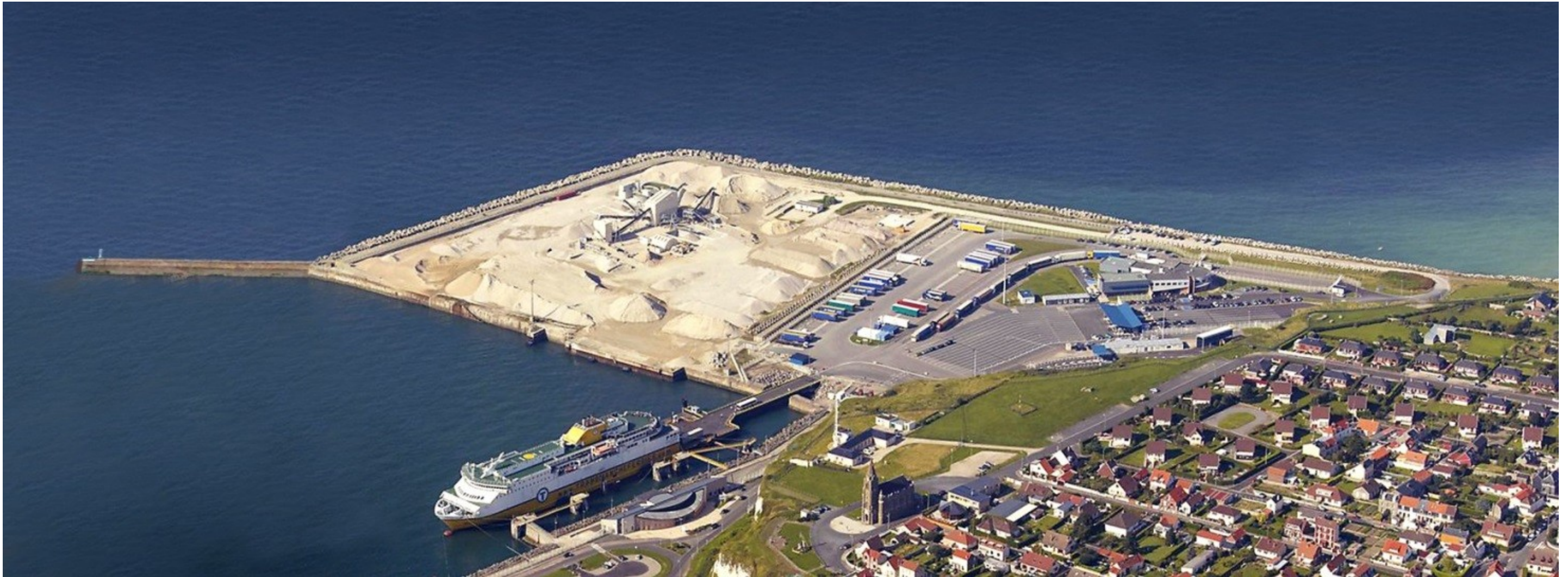
Figure 65 : Photomontages des nouveaux aménagements – grues télescopiques pliées puis grues déployées - point de vue 1 (Vue aérienne)
