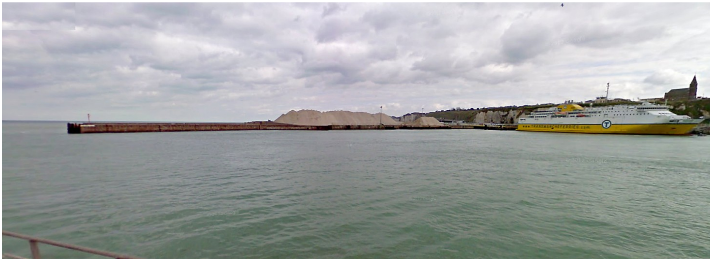
Figure 66 : Photomontages des nouveaux aménagements – grues télescopiques pliées puis grues déployées - point de vue 2 (Jetée ouest au niveau de la claire voie)
