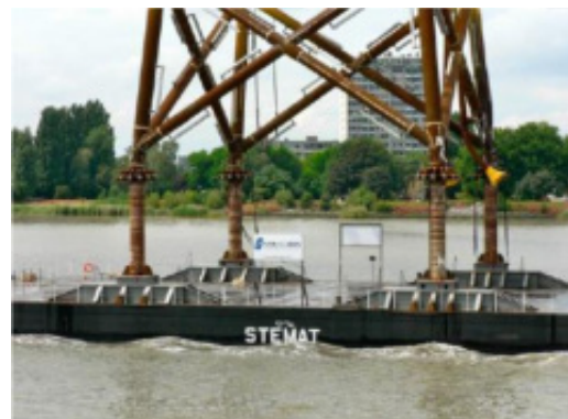
Chargement et mise en sécurité sur la barge ( www.heavyliftspecialist.com )
