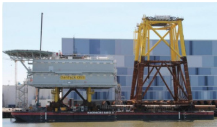
Figure 31 : Transport de la fondation et de la plateforme du poste électrique en mer
