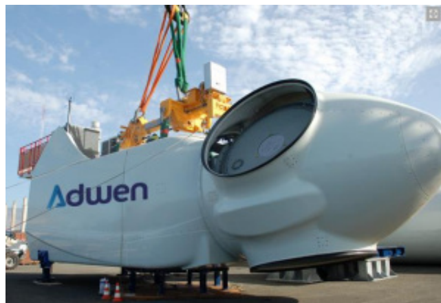
Figure 35 : Chargement de la nacelle
