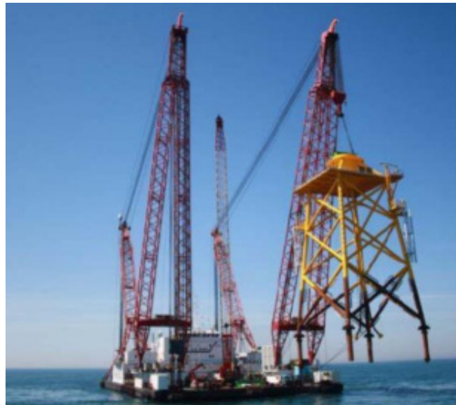
Figure 27 : Installation d'une fondation jacket
