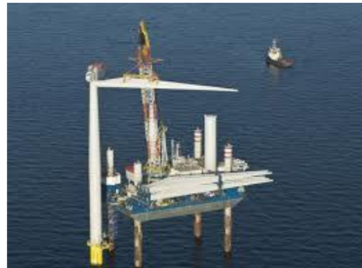
Figure 50 : Opérations de démantèlement des aérogénérateurs
