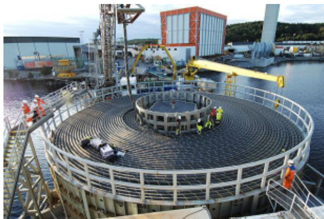
Figure 28 : Câble sur un navire câblier
