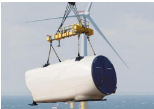
Dépose de la nacelle ( www.fk-wind.dk )
