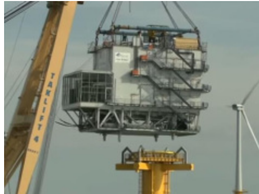
Dépose de la plateforme (Belwind video)
