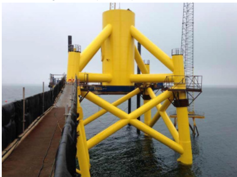
Figure 9 : Exemple d'une pièce de transition
