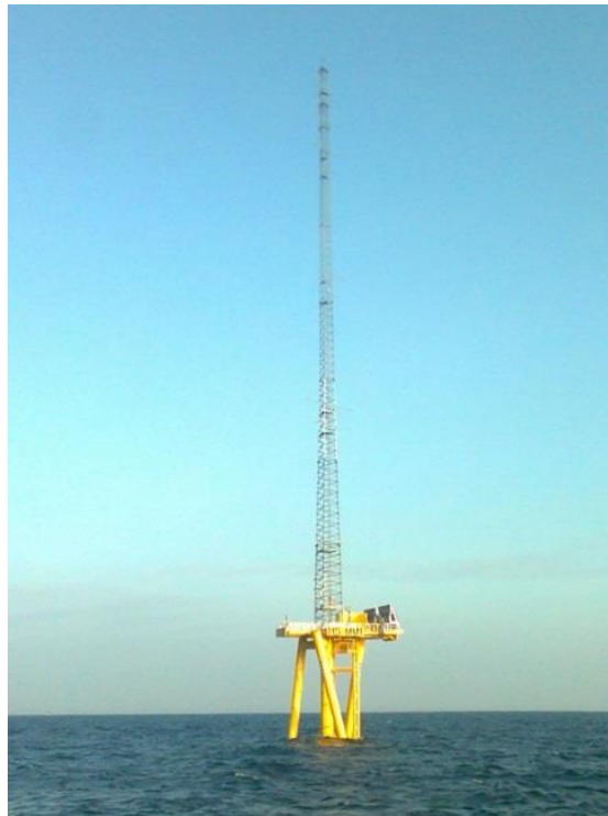
Figure 17 : Mât de mesure en mer
