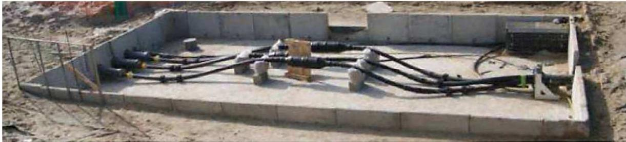
Figure 39 : Chambre de jonction d'atterrage-Source : Nexans, 2016
