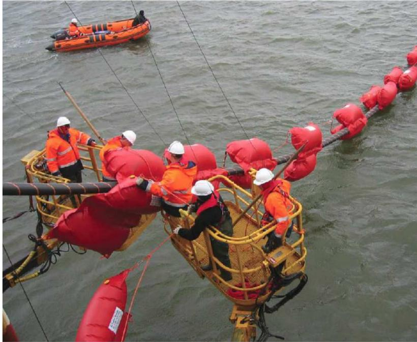
Figure 32 : Mise en place de flotteurs autour du câble durant la phase de tirage vers la cote – Source: Crown Estate
