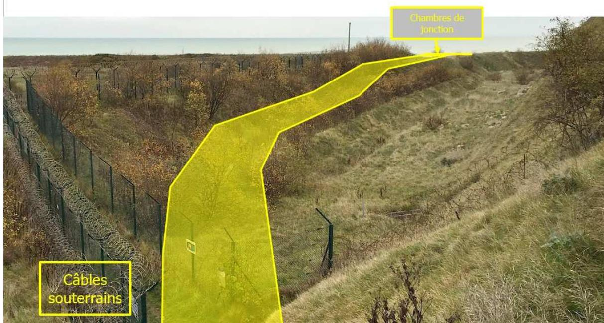
Figure 43: Passage des liaisons souterraines en pied de falaise
