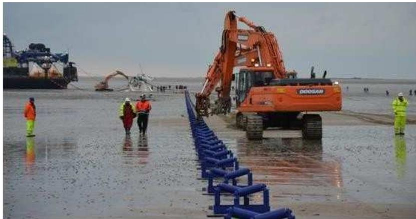
Figure 33 : Câble tiré par les pelleteuses du navire câblé vers la chambre d'atterrage
