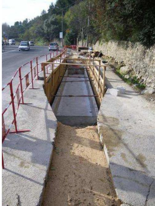
Figure 52 : Chambre de jonction pour une liaison composée d'un seul circuit 225 000 volts (RTE)
