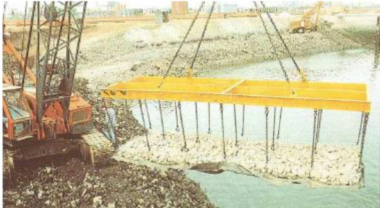
Figure 35 : Exemple de couverture en béton ou en géotextile
