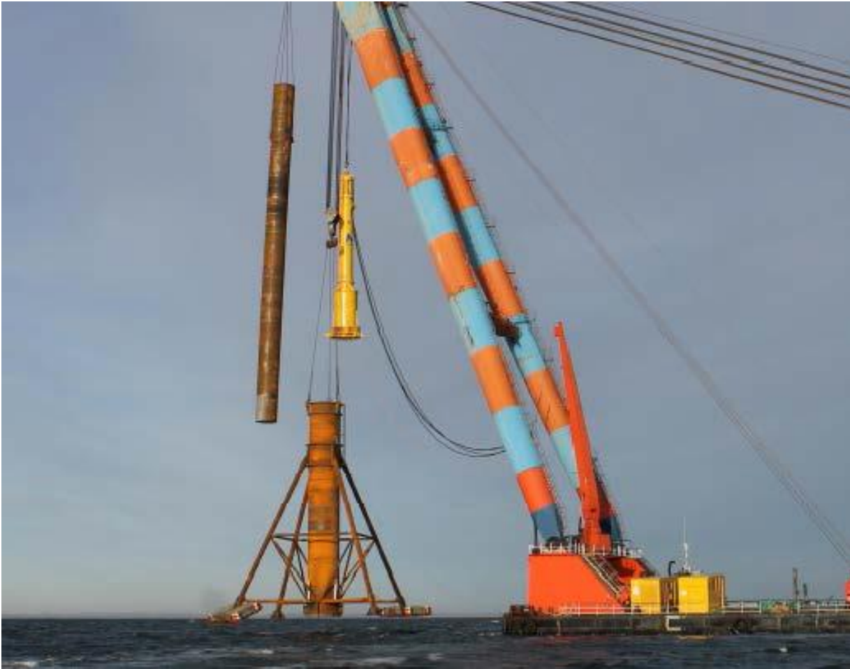
Figure 123: Batardeau de la société Lo-Noise en essai à Aarhus Bight).
