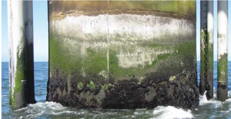
Figure 69. Aperçu d'une fondation colonisée sur sa partie supérieure au sein du parc éolien en mer de Throntonbank (Belgique)
