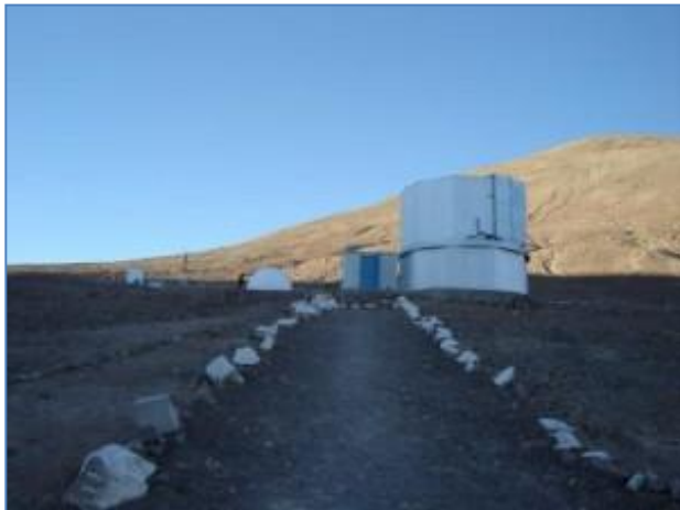
Figura 3-49: Imagen observatorio Cerro Armazones
