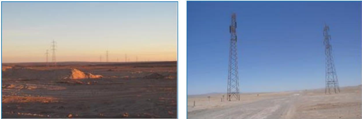
Figura 3-147: Líneas eléctricas que cruzan el Sector Ductos
