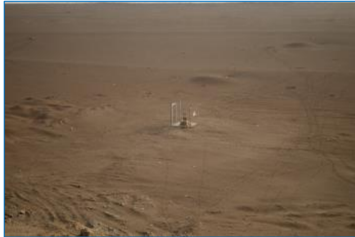
Figura 3-160: Captación agua de mar, Michilla
