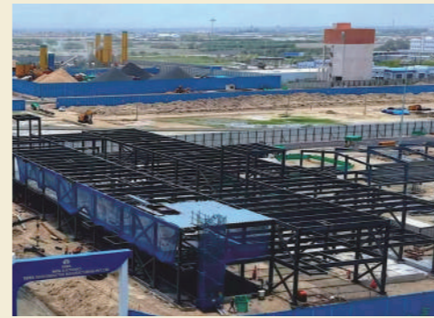
次世代半導体の集積地として開発が進むドレラ工業団地。インドの半導体大手Tata Electronics（タタ・エレクトロニクス）も同団地に工場を建設中だ
