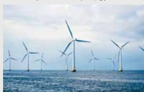
英国 Moray East 洋上風力発電 プロジェクト
