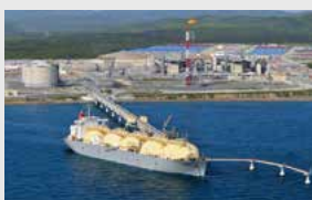
サハラII石油・天然ガス開発プロジェクト
