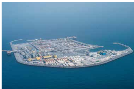
油・ガス田開発基地
