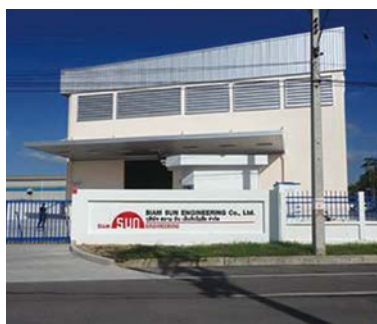
（株）サン・エンジニアリングのタイ現地法人がタイのチョンブリー県で行う機械設備の組立・設置事業に必要な資金を現地通貨建て（タイ・バーツ）にて融資。
