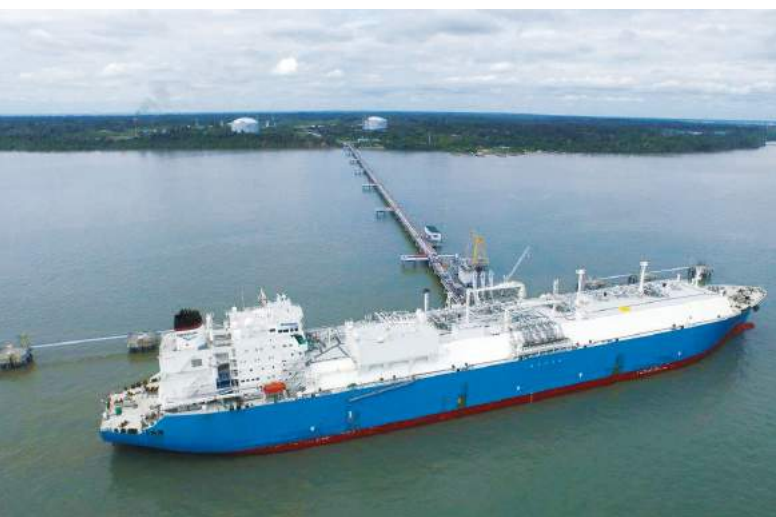
タンブー LNGプロジェクト
