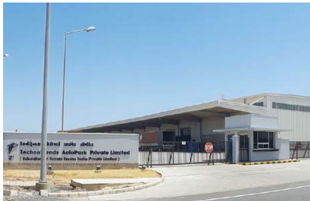
マンダル日本企業専用工業団地外観
