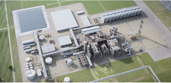
アンモニア製造プラントのイメージ(出典:CF Industries Holdings, Inc.)
