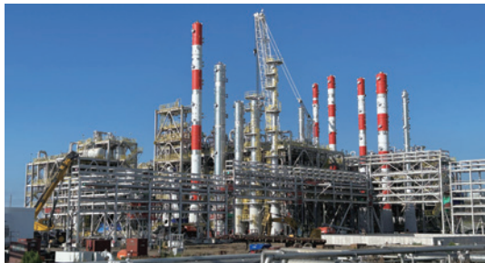
米国のDMC・EMC製造プラント(提供:UBE)
