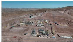
アルケロス鉱山建設現場 （提供：日鉄鉱業）
