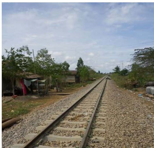
(シソボン付近の線路の様子)
