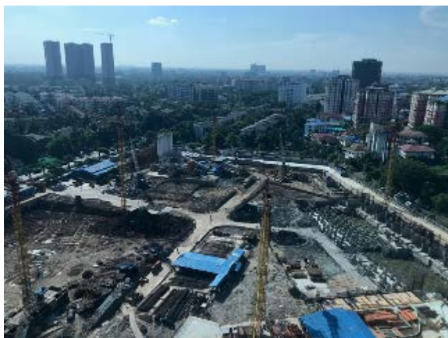
ヤンゴン中心部で開発中の土地
