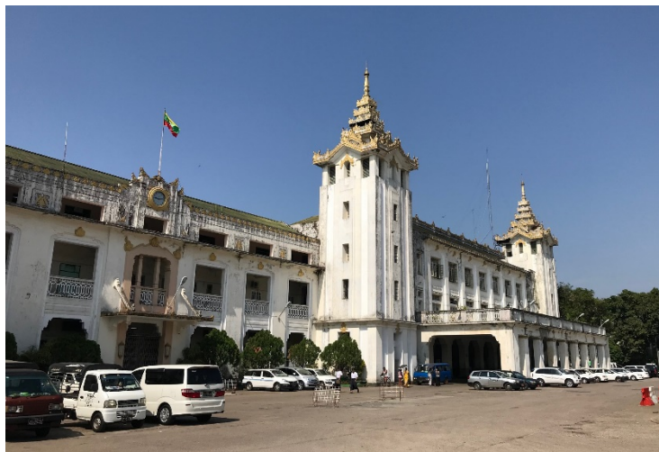
ミャンマーの鉄道網の玄関口「ヤンゴン・セントラル駅」
