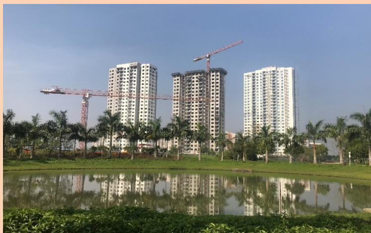
ティラワSEZ近郊で建設が進むスターシティー
