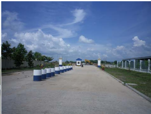
(マンハッタン SEZ 内部の様子)
