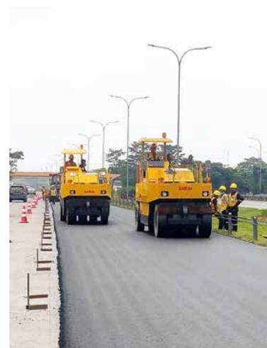
インドネシアでのリサイクルアスファルトの施工状況
