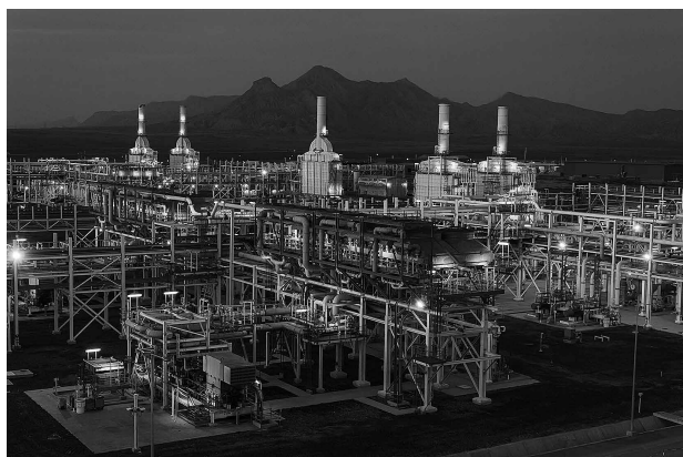
サンガチャル・ターミナル。ACG油田、BTC原油パイプライン、シャハ・デニズ ガス田、SCPガスパイプライン関連設備が所在する世界最大規模の陸上処理施設 (BPバクー事務所提供)
