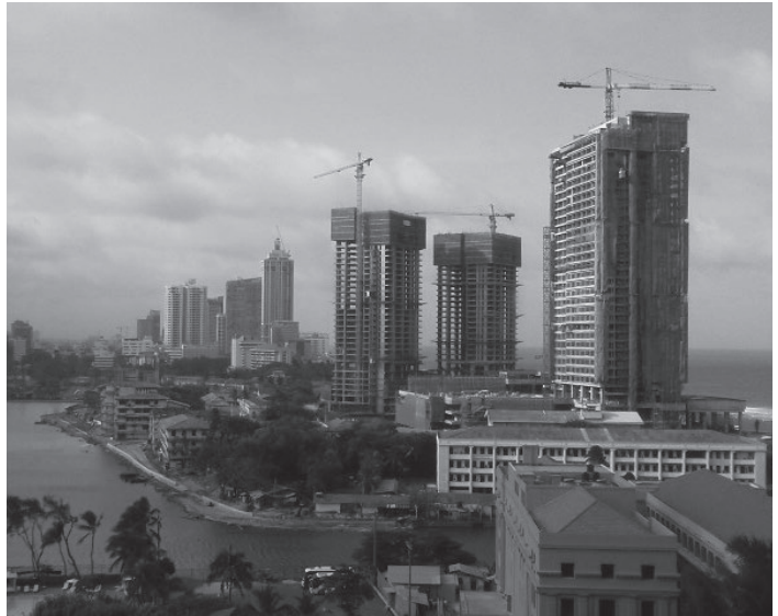
写真1：急ピッチで建設が進むホテル群（筆者撮影、以下同）
