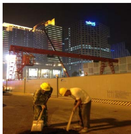
建設工事現場で作業に従事する労働者。都市化を実現するためには、農民工の労働力が必要である。(写真：成都市内)
