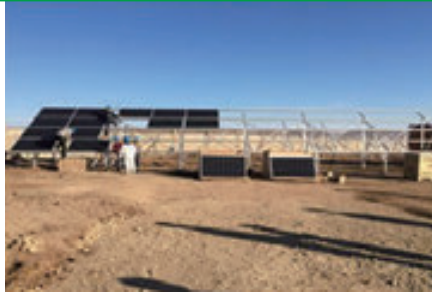
建設中の太陽光パネル(モンゴル)
