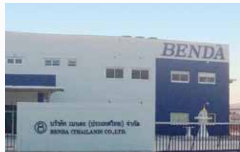
タイ生産拠点 BENDA (THAILAND) CO.,LTD. 工場
