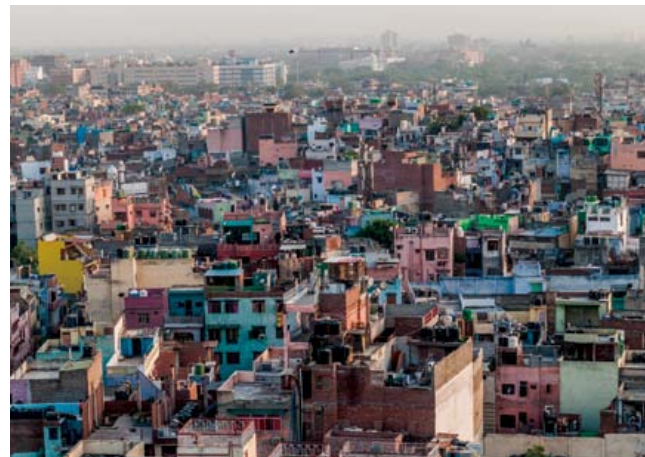
インド・デリー 建物の建設が進む
