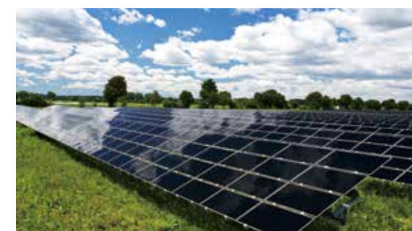
ファーストソーラー社の太陽光パネル。同社ではTCOガラスを使った高効率の最新型太陽パネルを製造する。
