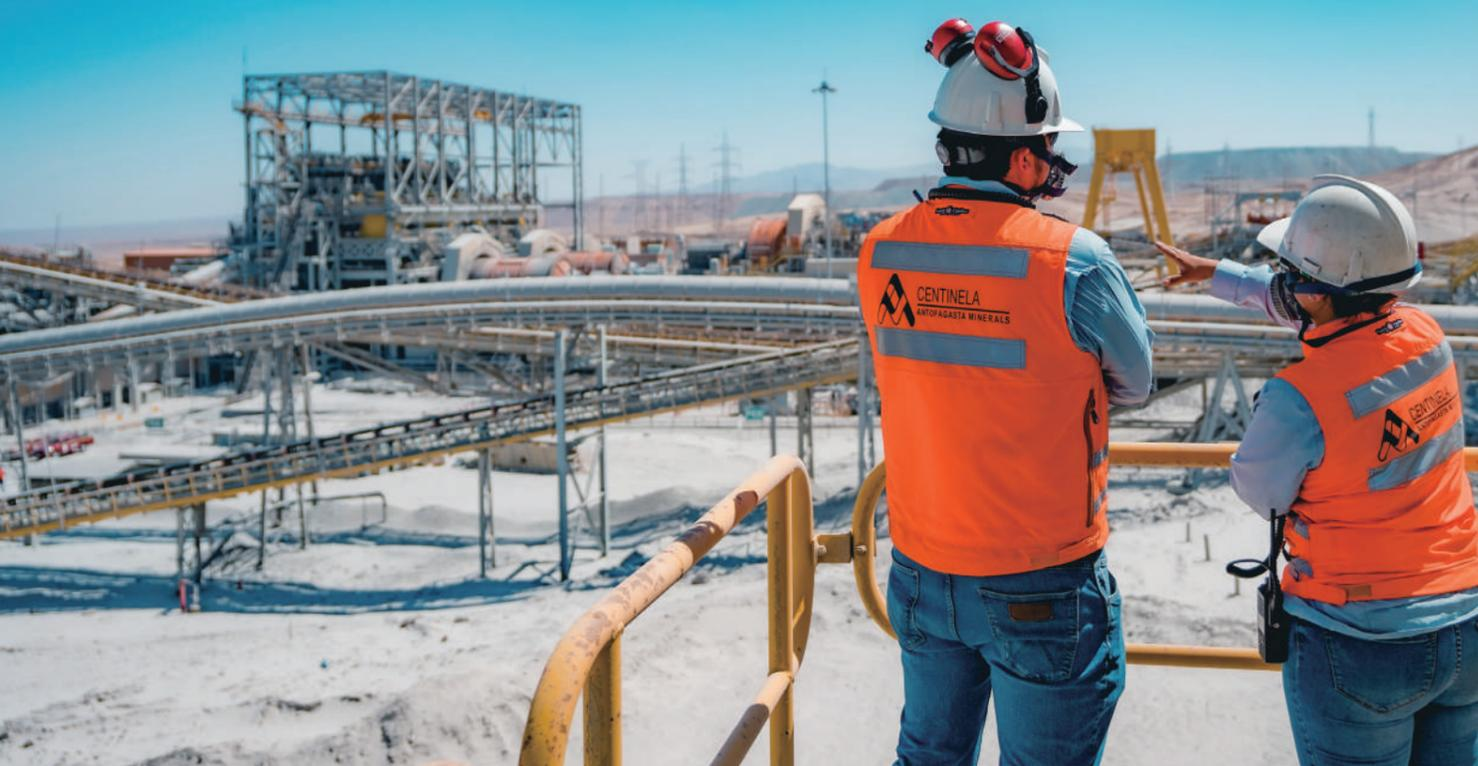
チリ北部のセンチネラ銅鉱山の鉱石を粉砕し、銅分を分離・回収する選鉱プラント
