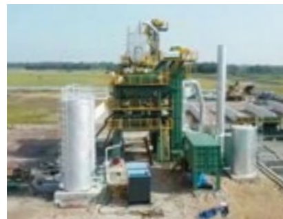
インドネシア マジャレンカ市に建設した2号機のリサイクルアスファルトプラント。
