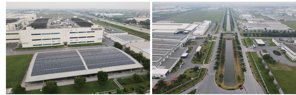
安定した電力供給と環境対応のため、タンロンでは工場屋根への太陽光発電パネル設置が進んでいる(左)/広大な敷地には洪水対策として雨水を貯めるための調整水路や調整池まで整備されていた(右、共に第2タンロン工業団地)
