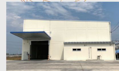
2023年に完成したタイ第二工場。敷地面積は3万5000平方メートル以上あり、従業員は100名を超える。OA機器のほか、新たに受注した小型電子機器の部品もここで手がける
