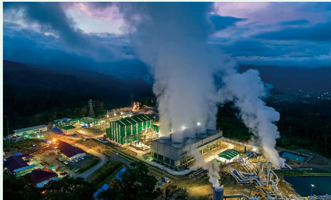
ムアララボー地熱発電所プラントの様子。既設プロジェクトに加え、拡張プロジェクトでは、発電出力約83MWの新プラント建造を計画している
