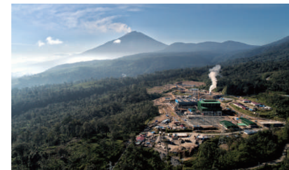
ムアララボー地熱発電所 写真提供：PT Supreme Energy Muara Laboh
