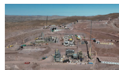
アルケロス鉱山建設現場 (提供:日鉄鉱業)
