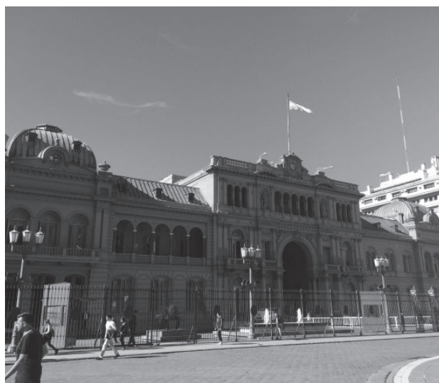
大統領府（カサ・ロサーダ）。晴天を背景にバラ色の外壁が引き立つ。外壁は建設当時（1800年代後半）の二大政党のカラーである赤と白を混ぜたバラ色が採用されたとのこと。
